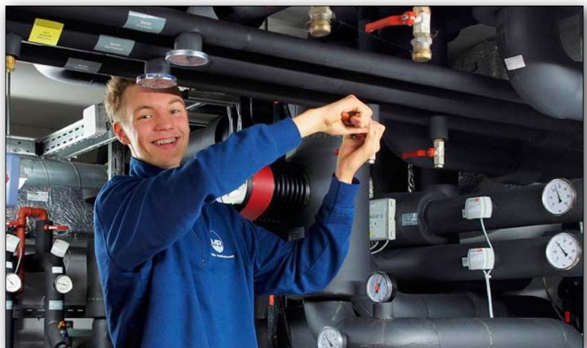
Fotos: Riedle Installationen GmbH
