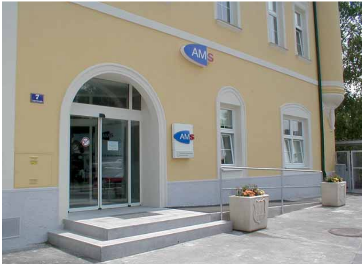
Die neue Geschäftsstelle des AMS Bruck/Leitha wurde im Sommer 2004 eröffnet.
